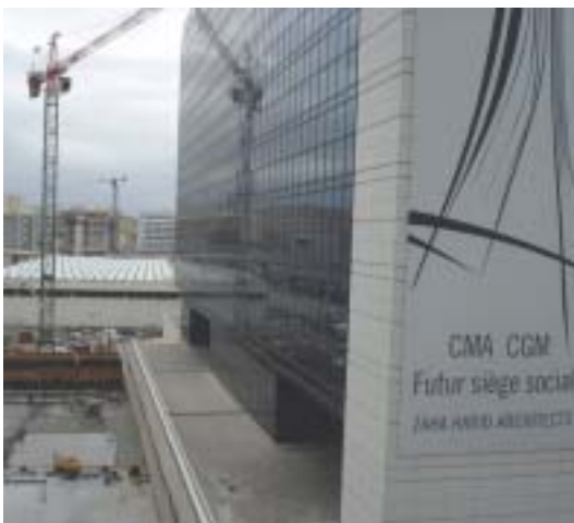
Chantier du siège social de CMA CGM à Marseille
