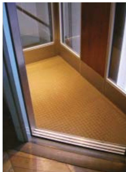
Dans un immeuble ancien, un ascenseur spécialement étudié pour le passage des fauteuils pour handicapés
